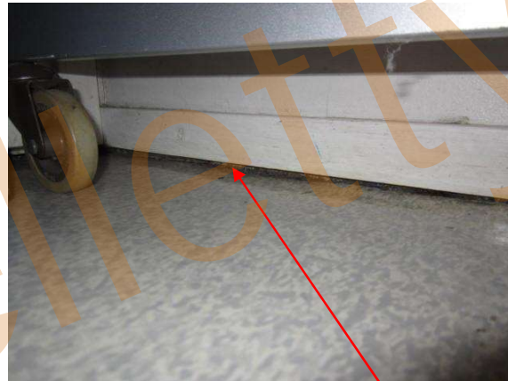
Jalkalistan ja muovimaton alla rakoa.
