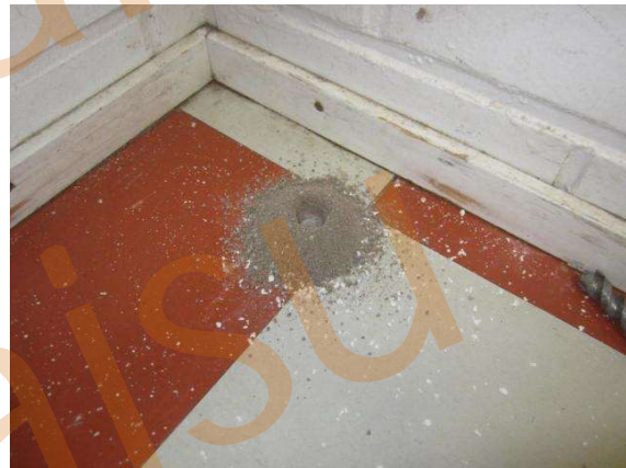
Porauksessa oli havaittavissa styroksieristettä ennen hiekkatäyttöä.
