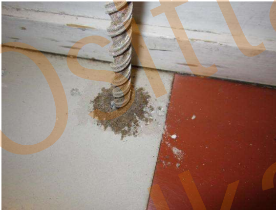
Porauksessa oli havaittavissa styroksieristettä ennen hiekkatäyttöä.
