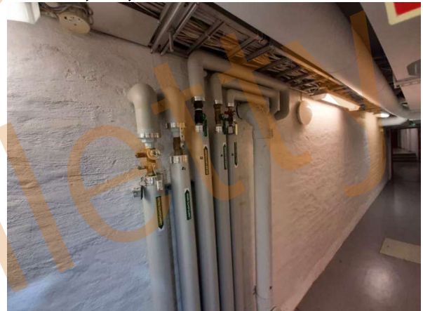
133. Käyttöveden linjaventtiileitä.
