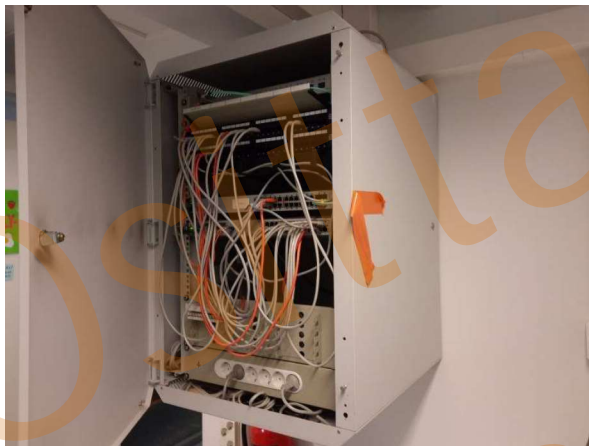
212. Yleiskaapeloinnin ristikytkentäteline.
