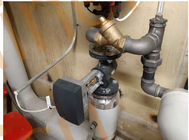
119. Säätöventtiileitä.
