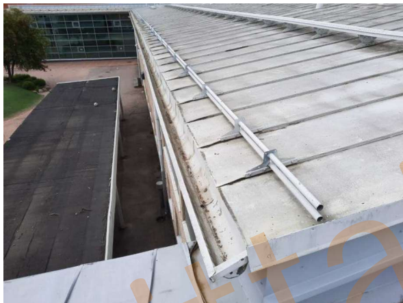
69. Vesikattoa ja varusteita A-osalla. Katoksessa bitumikate.
