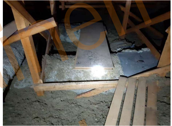
165. Ilmanvaihtokanavien eristystä.
