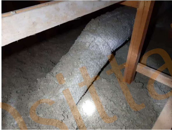
164. Ilmanvaihtokanavien eristystä.
