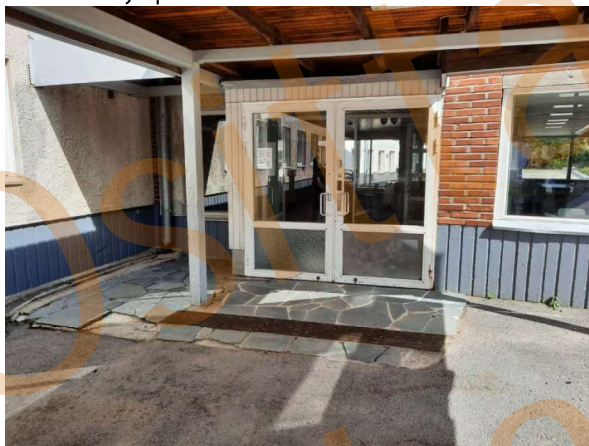
67. Metallirakenteinen ulko-ovi.
