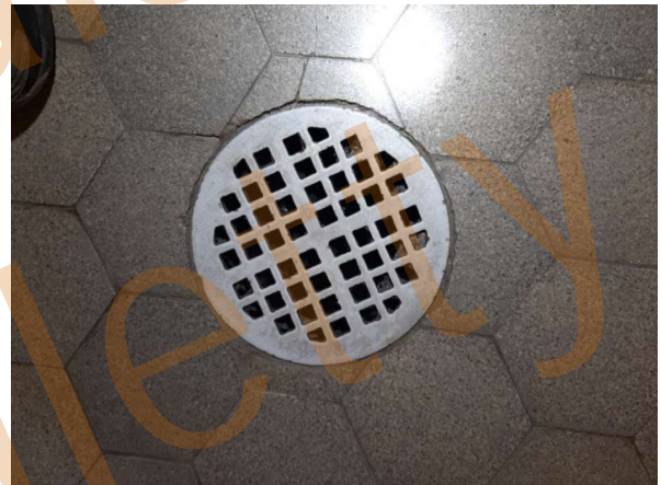
137. Alkuperäinen valurautainen lattiakaivo.
