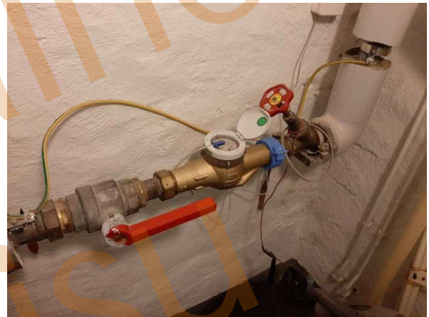
129. Kiinteistön päävesimittari.
