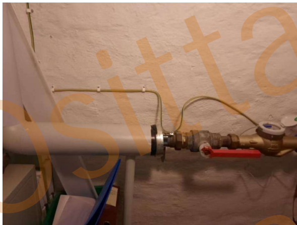
193. Putkistojen maadoituksia.
