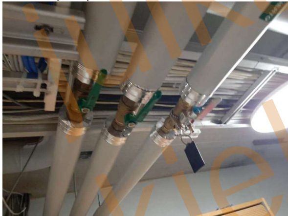
132. Käyttöveden linjaventtiileitä.
