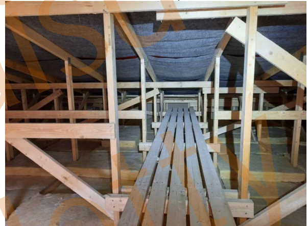
39. Kuvaa runkorakenteista ruokalan yläpohjassa.
