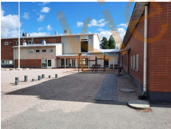
16. Kuvaa kulkuväylien pinnoitteista.
