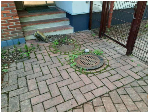
6. Kattovesien ohjausta A-B osan kohdalla, kaivo hieman korkealla.
