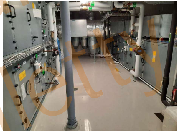
83. Ilmanvaihtokonehuoneen rakenteita C-osa.
