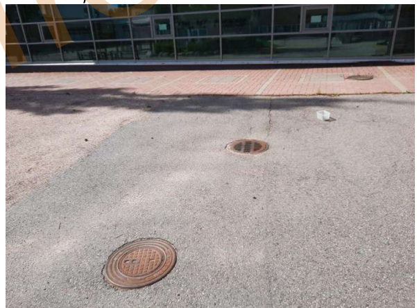
17. Kuvaa kulkuväylien pinnoitteista.
