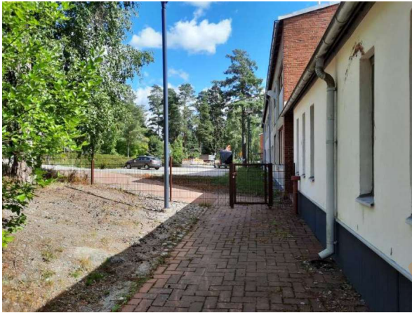
18. Kuvaa kulkuväylien pinnoitteista.
