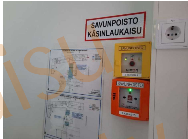
221. Savunpoistojärjestelmän laukaisupainikkeita.
