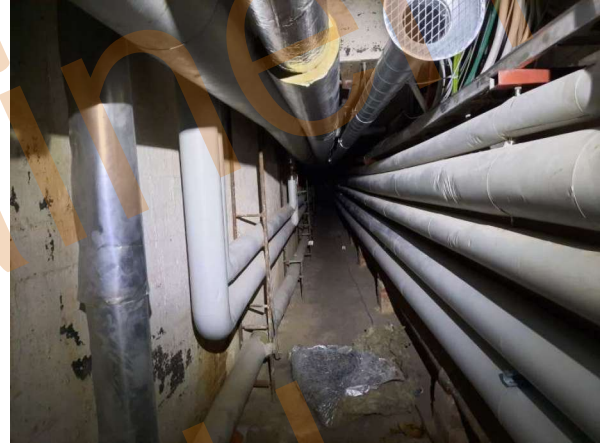
37. Kuvaa runkorakenteista putkikuilussa.
