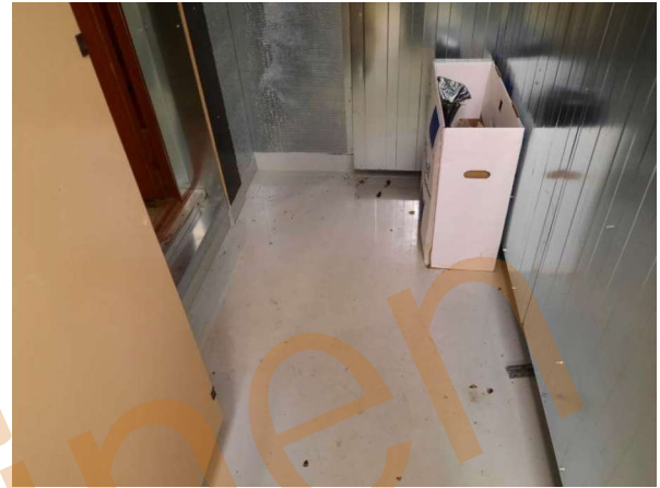
85. Ilmanvaihtokonehuoneen rakenteita D-osa.
