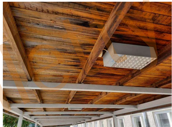
185. Matalan sisäpihan katoksen aluevalaistusta.
