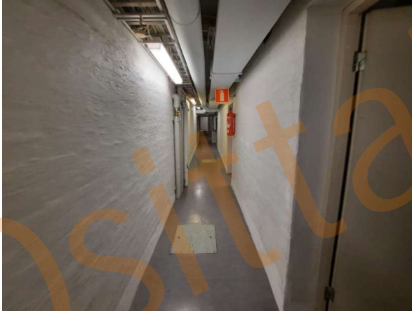
36. Kuvaa runkorakenteista kellarissa.
