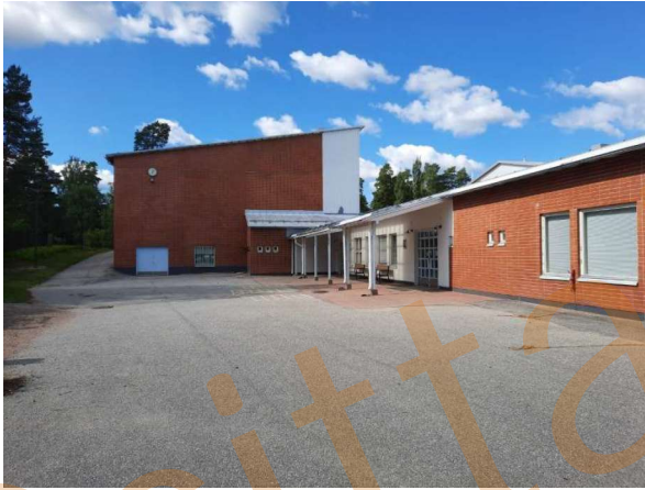
40. Kuvaa julkisivuista D-osalla.
