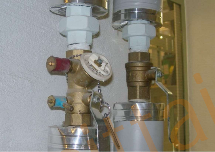
Kuva 15: Lämpöjohton palloventtiilit.
