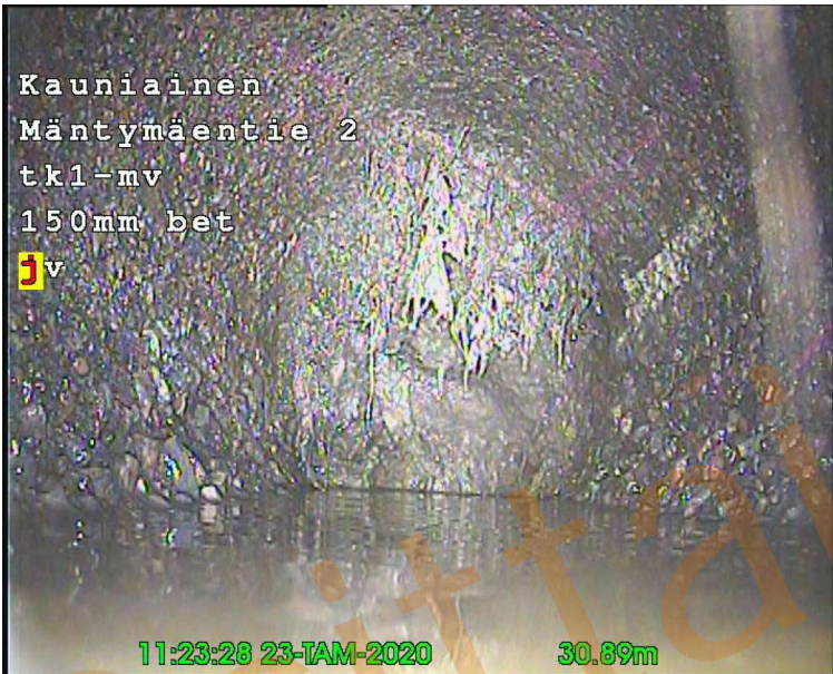
Kuva 11: Juurikasvusto tukkinut tonttviemärin.
