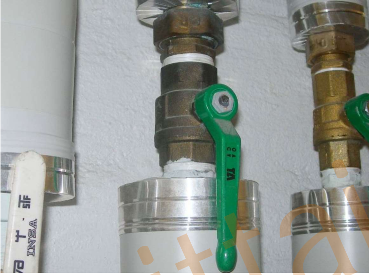
Kuva 3: Kylmänveden palloventtiili.
