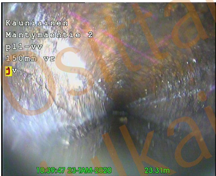
Kuva 9: Kivistymää pohjaviemäriputkessa.
