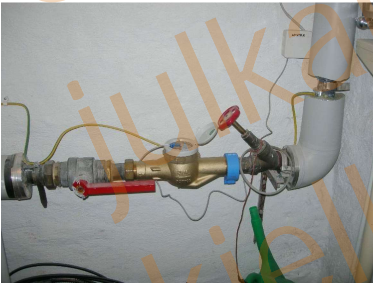
Kuva 1: Vesimittari.
