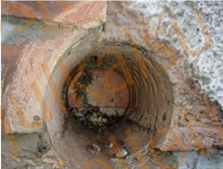
Kuva 9. Rakenneavaus, RAK1, pohjoissivun sokkelin ja julkisivun rajapintaan.
