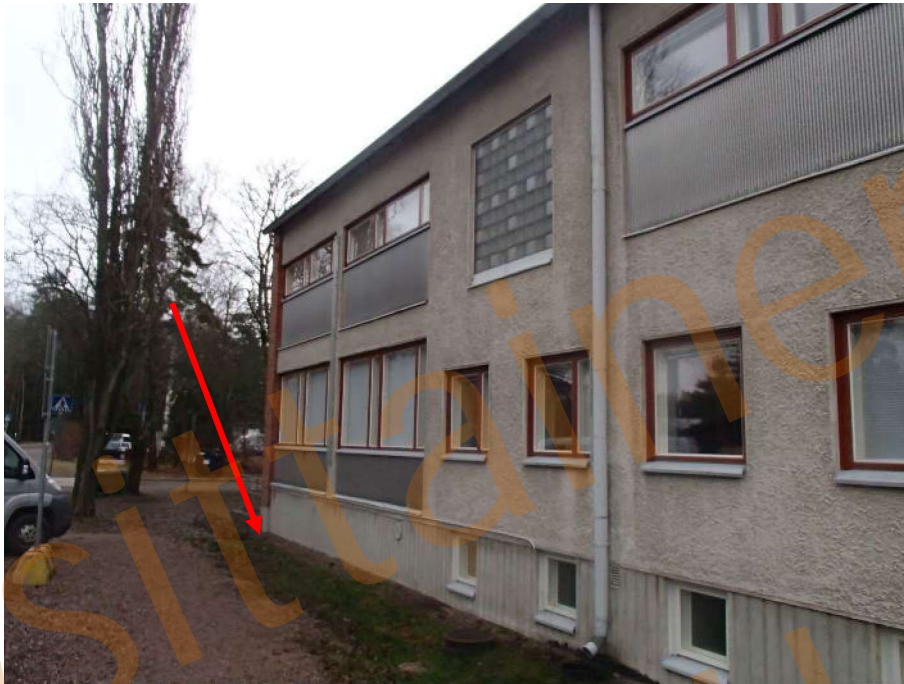
Kuva 47. Mäntytien puoleisella sivulla maanpintojen kaadot eivät ole suositusten mukaiset.
