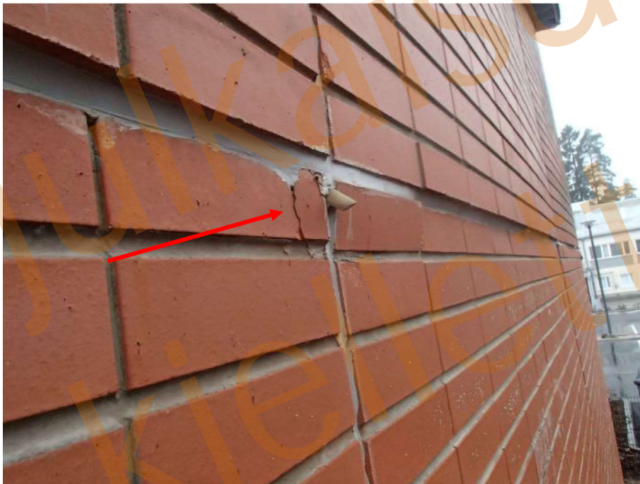
Kuva 67. Julkisivuelementtien vaurioitumista.
