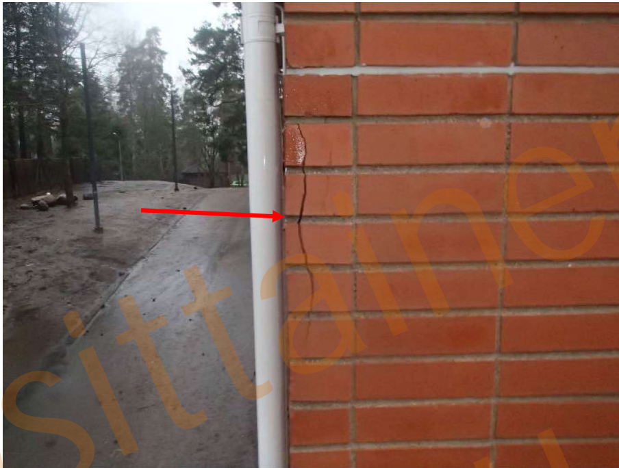
Kuva 66. Julkisivuelementtien halkeilua.
