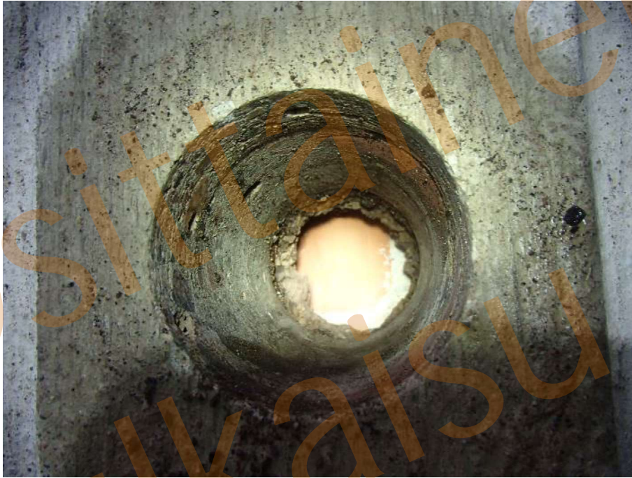
Kuva 5. Rakenneavaus, S3, ruokalan sokkeliin.
