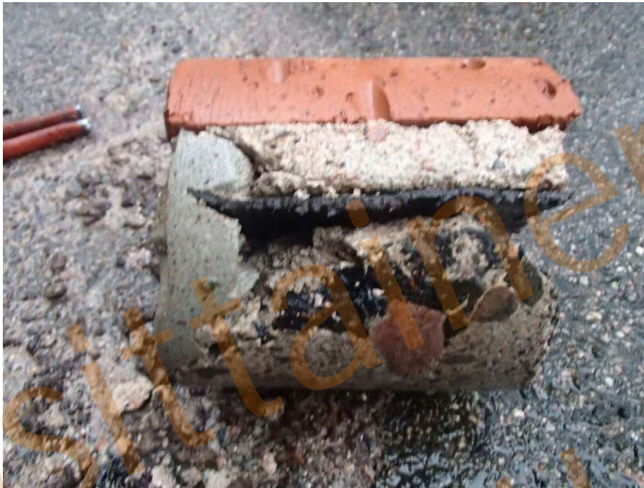
Kuva 12. Rakenneavaus, RAK3, itäsivun sokkelin ja julkisivun rajapintaan.
