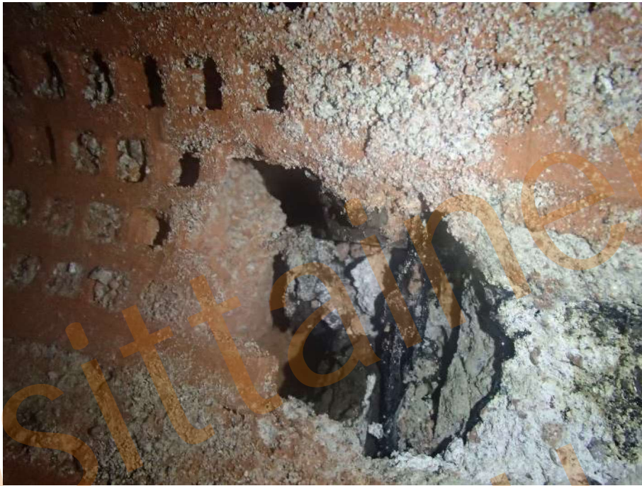
Kuva 16. Rakenneavaus, RAK5, sisäpihan sokkelin ja julkisivun rajapintaan. Kuvassa ilmarako korkkieristeen taustalla.
