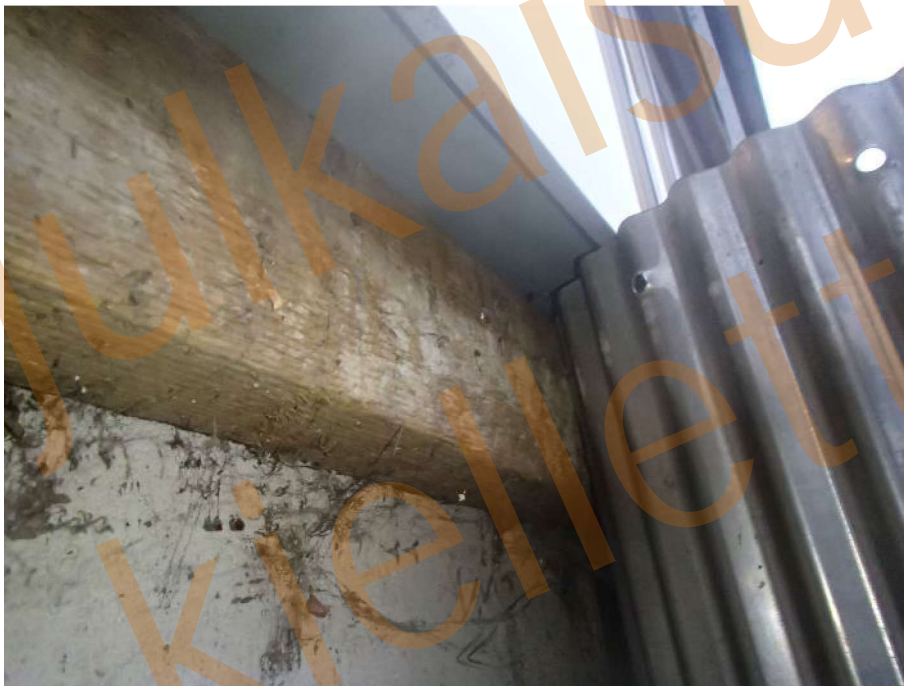
Kuva 18. Rakenteet pellityksen taustalla.
