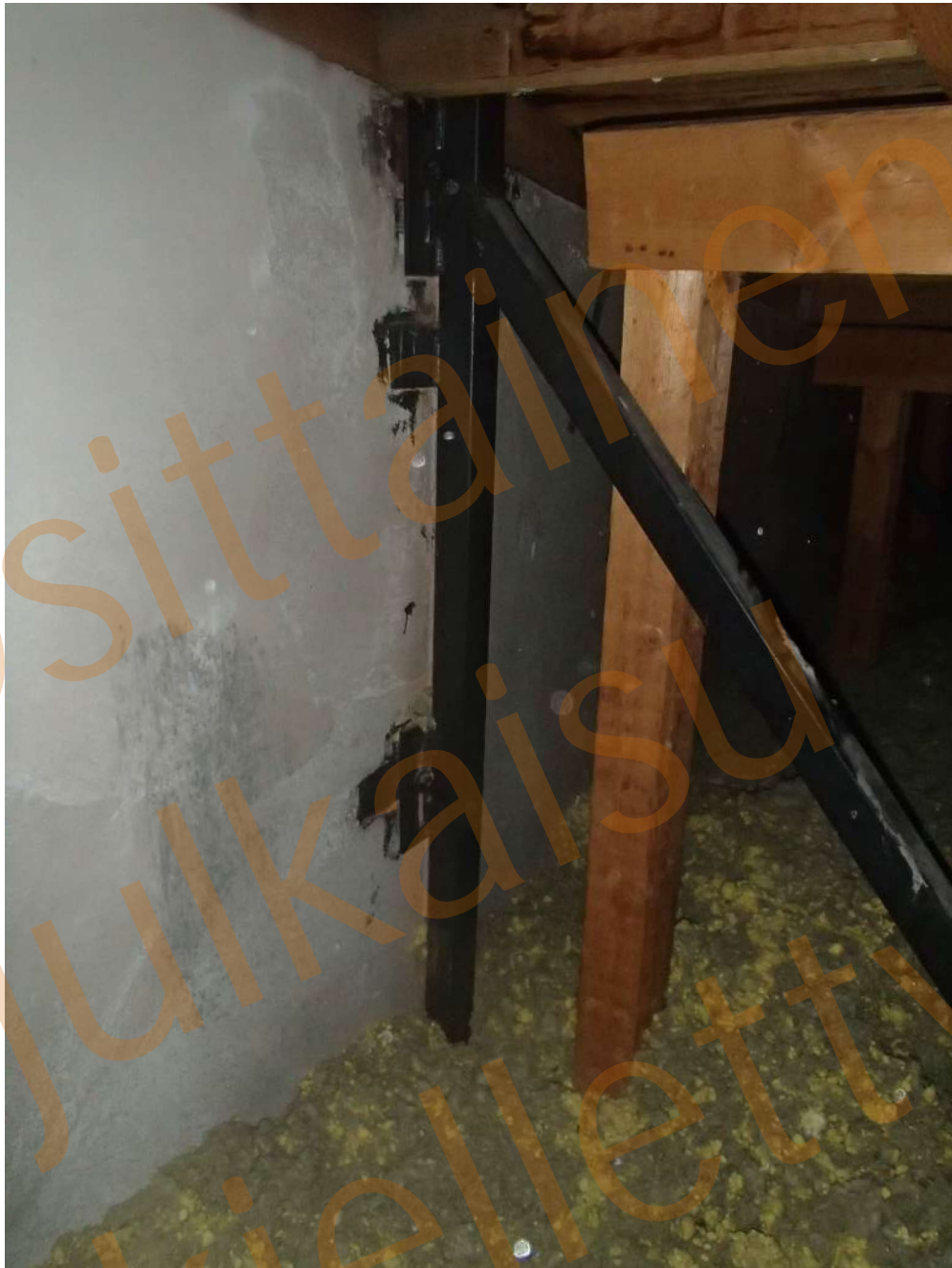
Kuva 72. Julkisivun yläpohjan vastaisten elementtien kiinnitys yläpohjaan.
