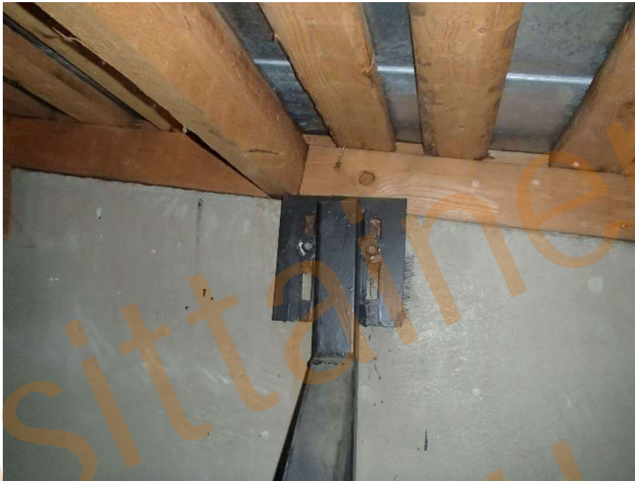
Kuva 101. Liikuntasalin räystäärakenteita sisäpuolelta.
