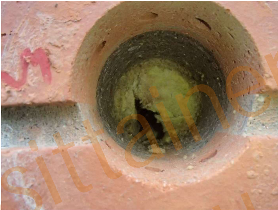
Kuva 63. Rakenneavaus julkisivuun.
