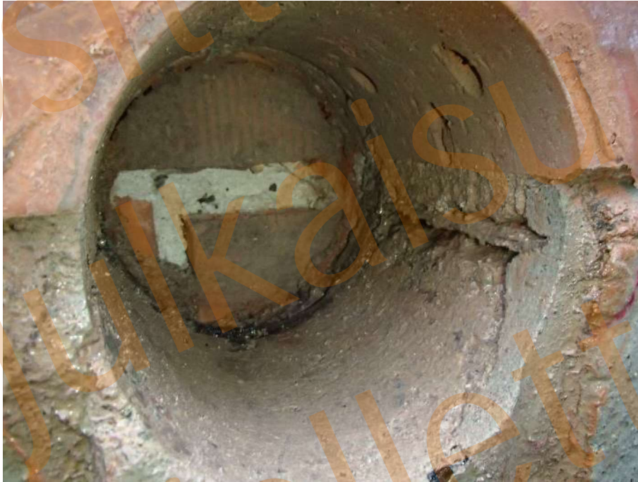
Kuva 11. Rakenneavaus, RAK3, itäsivun sokkelin ja julkisivun rajapintaan.
