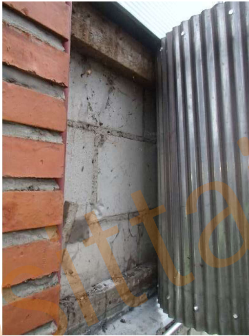
Kuva 17. Rakenteet pellityksen taustalla.
