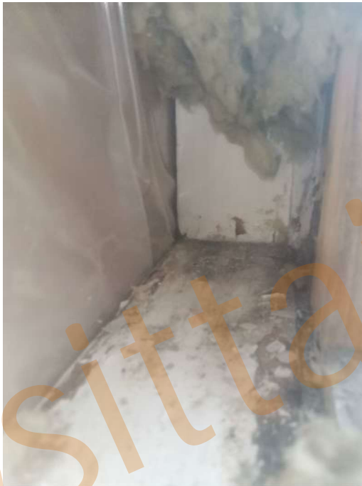
Kuva 55. Mineraalilevyjen taustalla on vanhat ikkunakarmit, jotka toimivat levytyksen runkona. Mineraalilevyjen taustalla ei ole tuuletusta.
