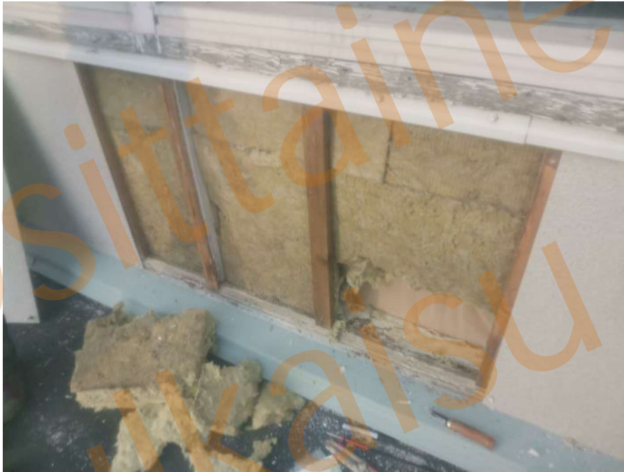
Kuva 19. Rakenteet pellityksen taustalla.
