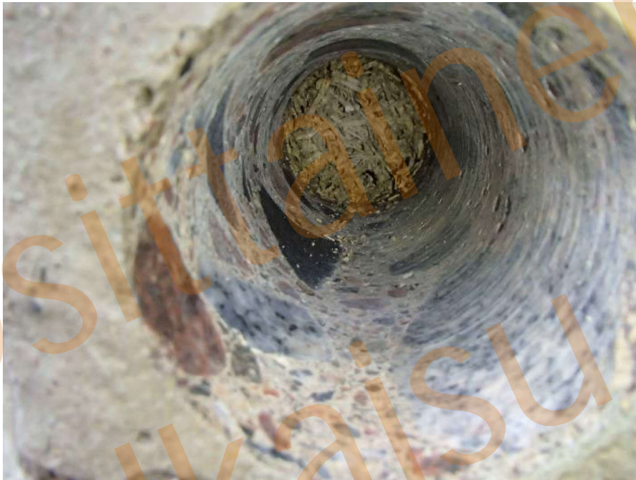
Kuva 1. Rakenneavaus, S1, pohjoissivun sokkeliin.
