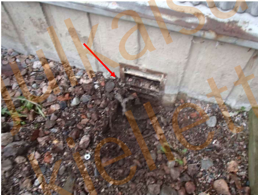
Kuva 46. Mäntytien puoleisessa sokkelissa on osin ja kokonaan korvausilmakanavia maan alla.
