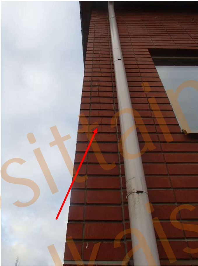
Kuva 65. Julkisivuelementtien halkeilua.
